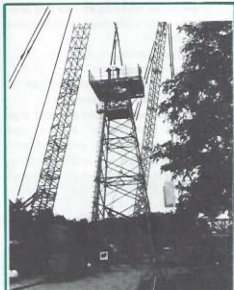
De toren wordt tijdelijk op de grond naast de gebouwen geplaatst.
