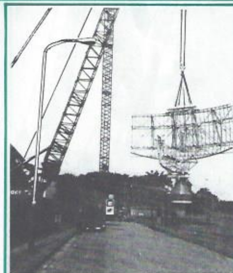
De antenne wordt van de toren gelicht.
