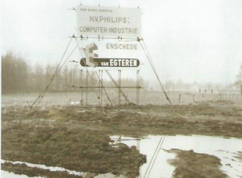
Het braakliggend bouwterrein.
