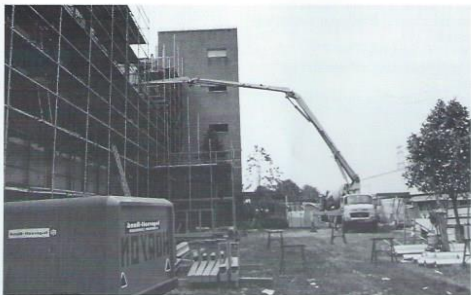
De herstellwerkzaamheden in gebouw F in volle gang.
