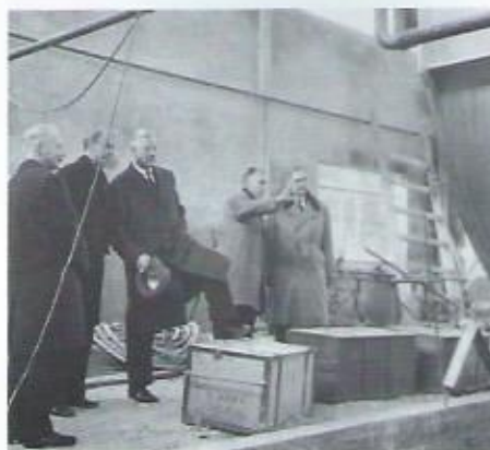
Bezoek heren Philips en Tromp in het in aanbouw zijnde ketelhuis.
